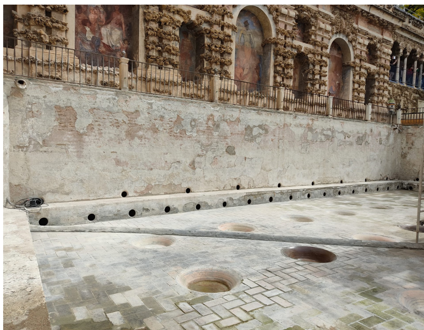
Trabajos de retirada de cal y recuperación de las paredes del vaso del estanque, 2024. Hermanos Campano S.L.
