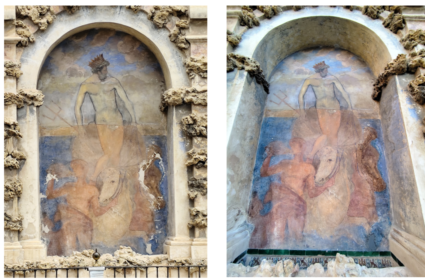
Antes y después de nicho del Grutesco, 2023. Marve Conservación y Restauración S.L.
