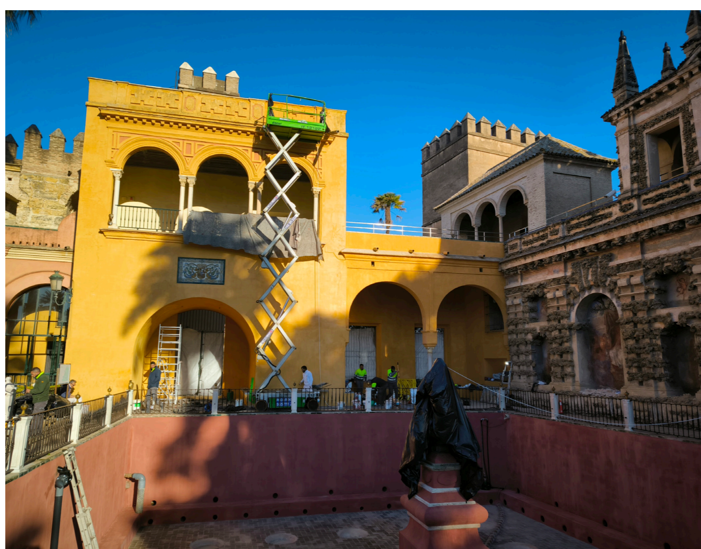
Trabajos de pintura en la fachada del Cenador del Chorrón, 2024. Hermanos Campano S.L.
