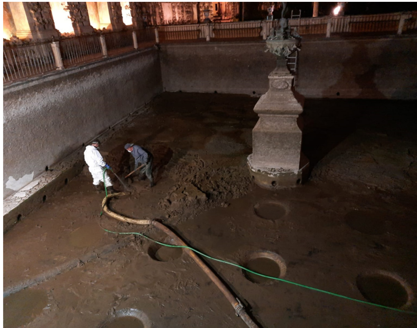
Trabajos de retirada de lodo en el estanque, 2022. Marve Estucos y Decoración S.L.
