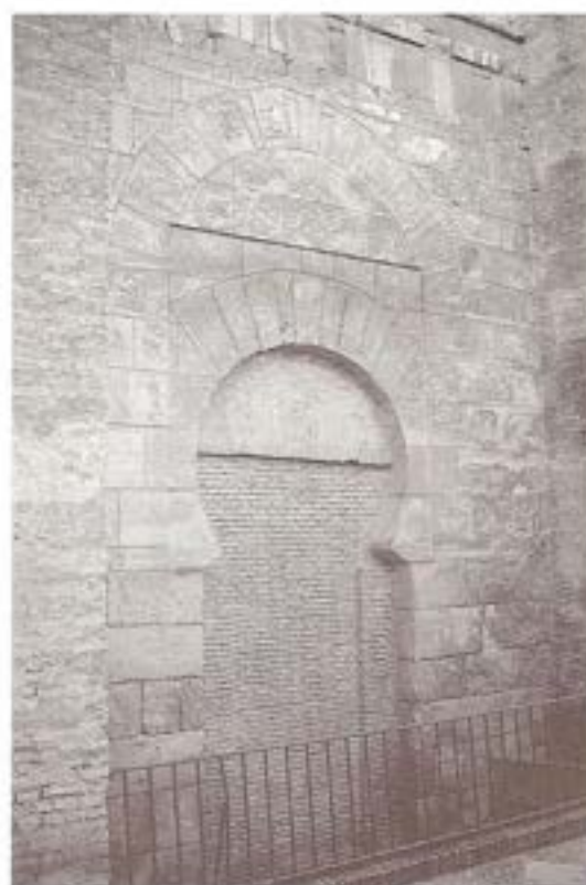
Foto 8. Antigua puerta de acceso al Alcázar.
