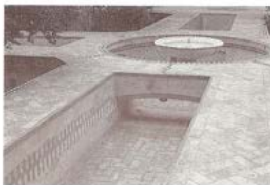
Foto 10. Patio de Crucero. Detalle de los andenes y albercas.
